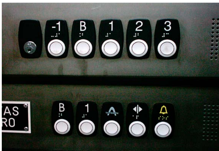
Botonera horizontal del interior de la cabina del ascensor
