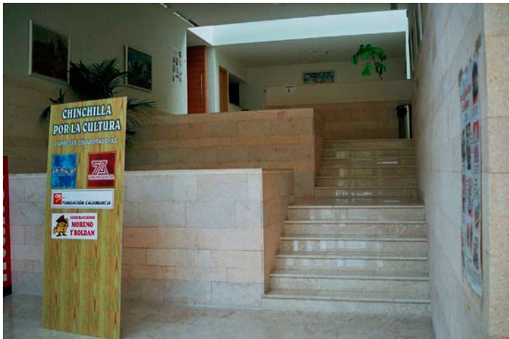
Comunicación vertical entre plantas mediante escaleras. Nótese la ausencia de pasamanos, la presencia de bocel en la tabica y el pavimento deslizante. Asimismo a destacar la falta de contraste cromático entre los suelos y los paramentos verticales
