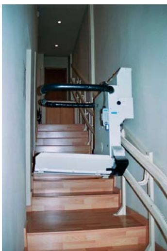
Detalle de plataforma salvaescaleras instalada en escalera interior de acceso a palcos. Nótese el notable desnivel a salvar, lo estricto de las dimensiones disponibles y la ausencia de pasamanos en la escalera por falta de espacio.
