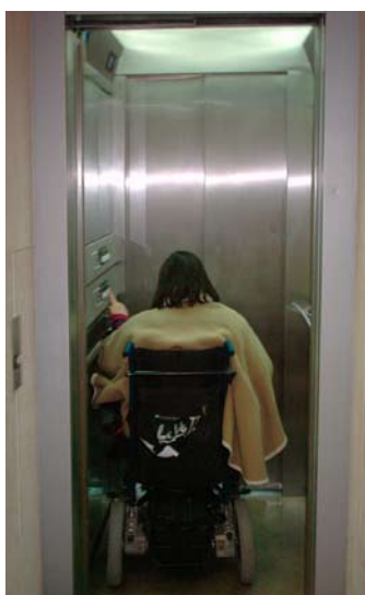
Botonera horizontal del interior de la cabina del ascensor
